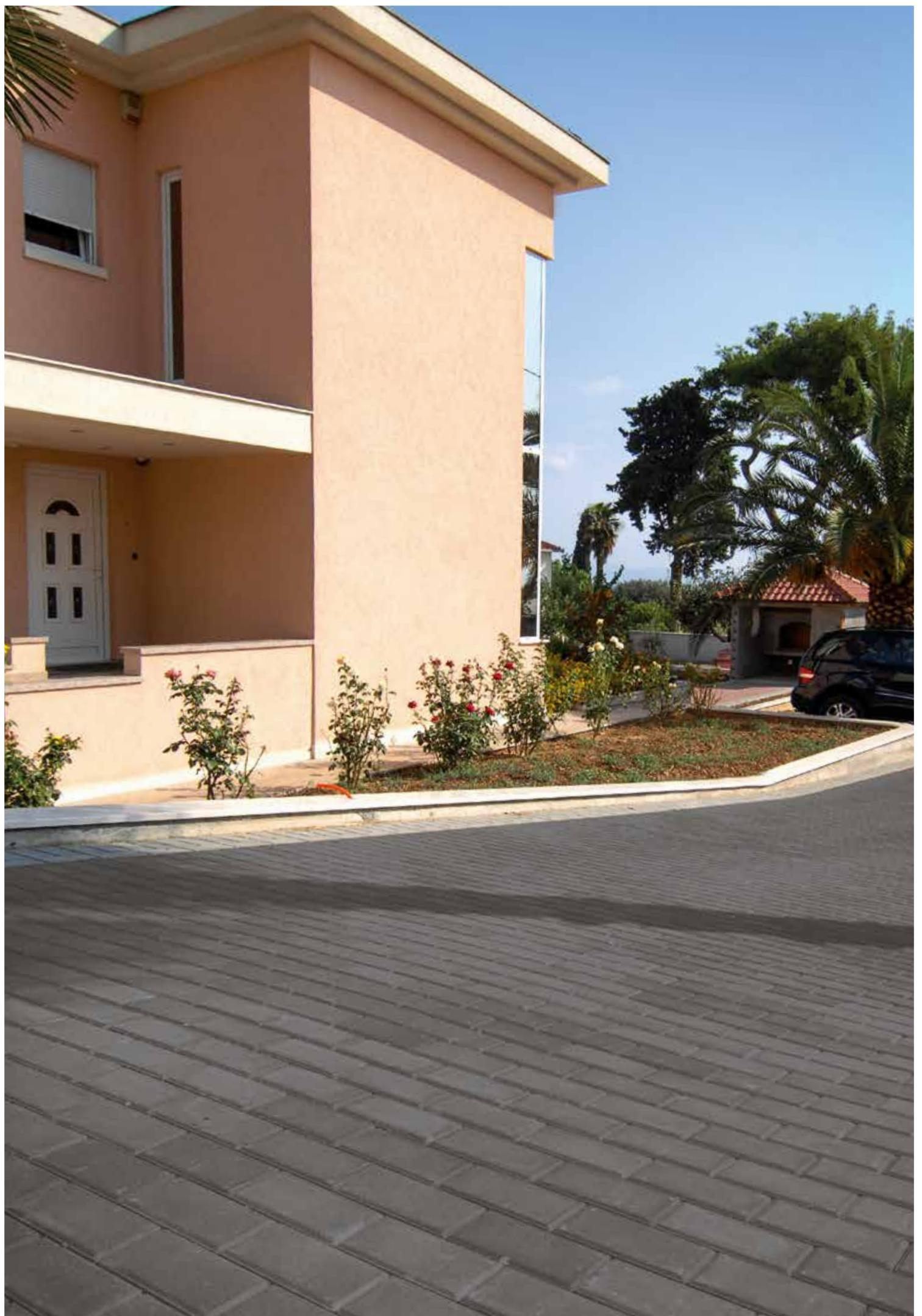
Klasični, vrlo otporni betonski opločnik proizvodi se u debljini od 6 cm. Nalazi primjenu na izrazito frekventnim i jako opterećenim površinama, bilo da se radi o industrijskim pogonima, lukama, teretnim i putničkim terminalima kao i prilazima prometnicama. Kombinacijom četiri veličine ovog opločnika dobivaju se razni kvadratni oblici mirnih i disreptivnih linija.
